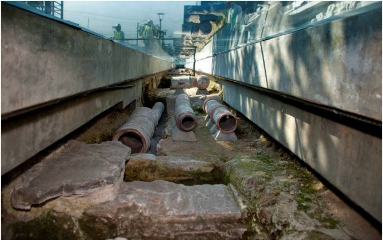
Imagen 6 Cañerías coloniales hechas de barro cocido encontradas en ciudad Guatemala, técnica de construcción utilizada en toda la América Hispánica.
