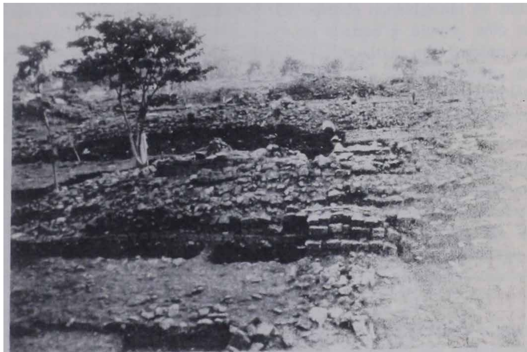
5. Estructura 191-N, vista hacia el este.
